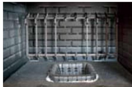
Camera di combustione con griglia sollevata
